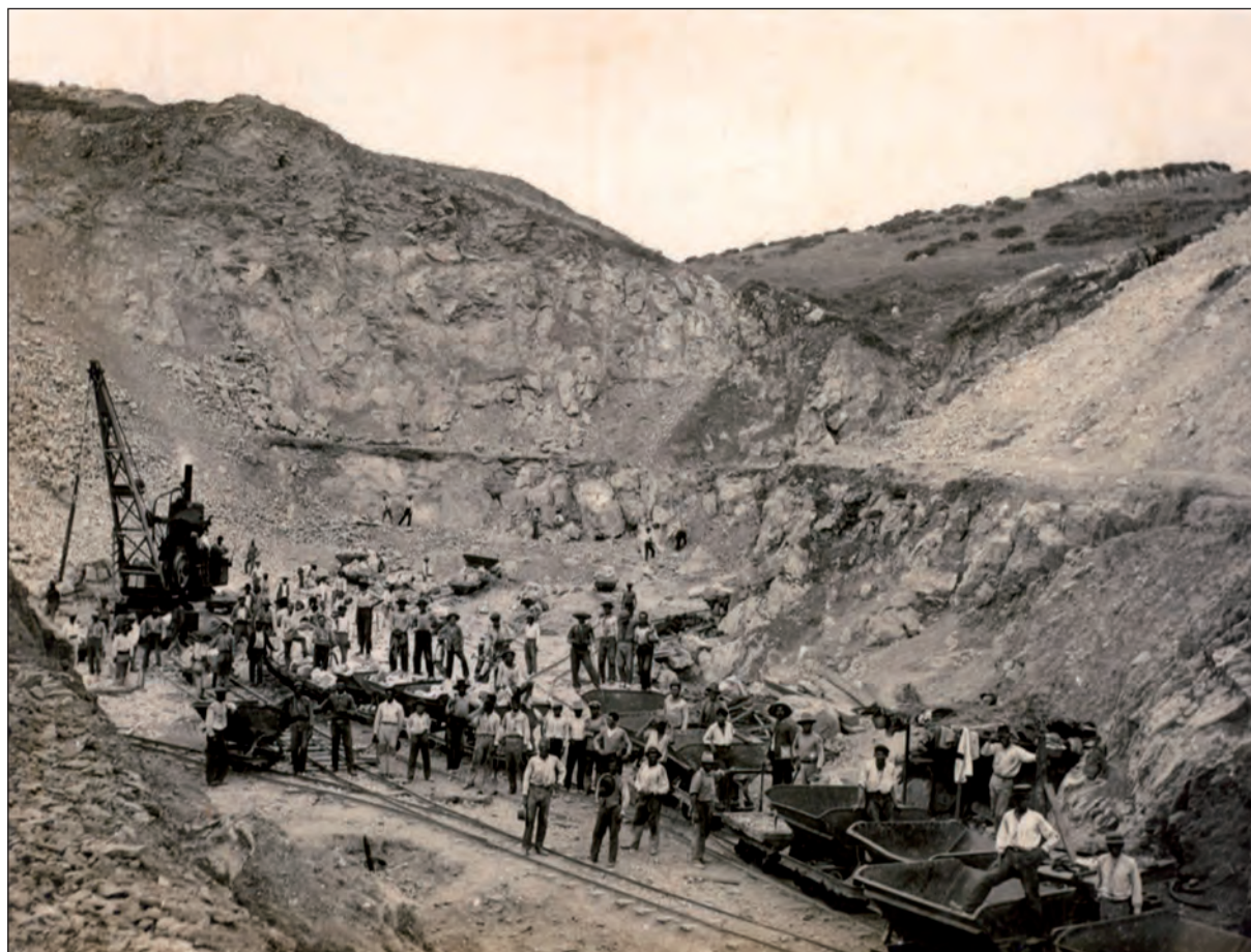
Lámina 6. La cantera de los Guijos y las vagonetas para el transporte de piedras. Hacia 1929 (Archivo Fotográfico de la A.P.B.A.)
