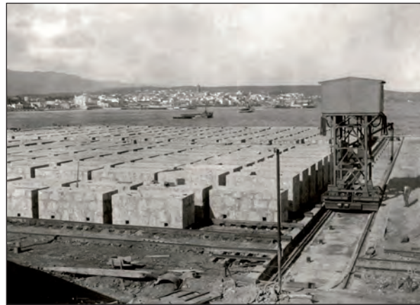
Lámina 11. Vista parcial del almacén de bloques. Véase el “Goliat” y las vías para su desplazamiento. Hacia 1927. (Archivo Fotográfico de la A.P.B.A.)
