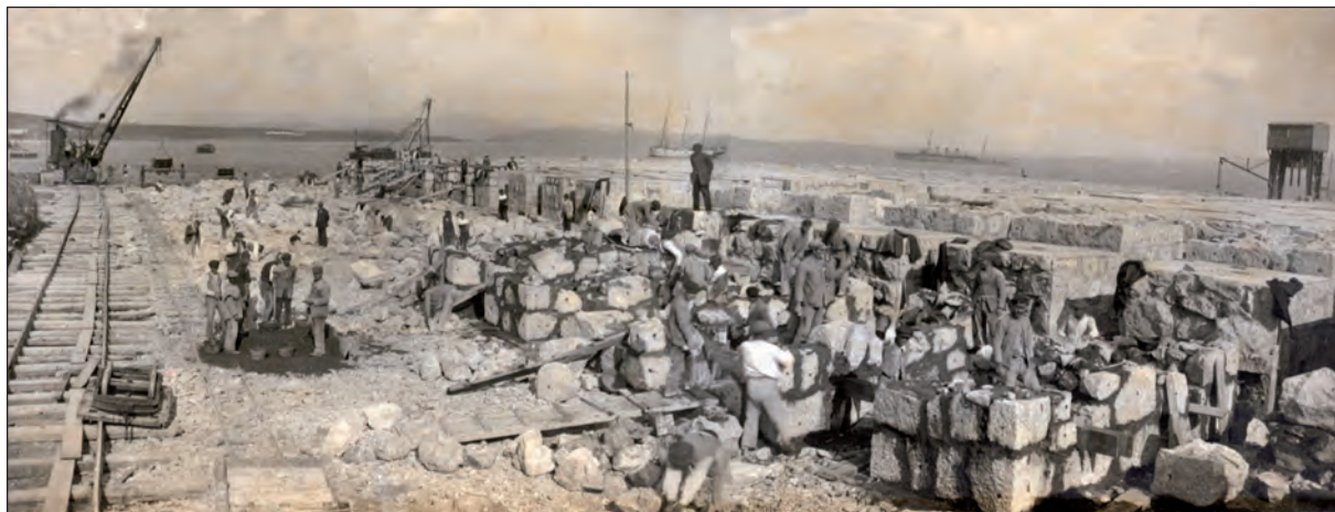
Lámina 12. VEI taller de bloques de la Isla Verde. Véase la técnica de fabricación a modo de mampostería con rocas calizas y cemento. Hacia 1927 (Archivo Fotográfico de la A.P.B.A.)
