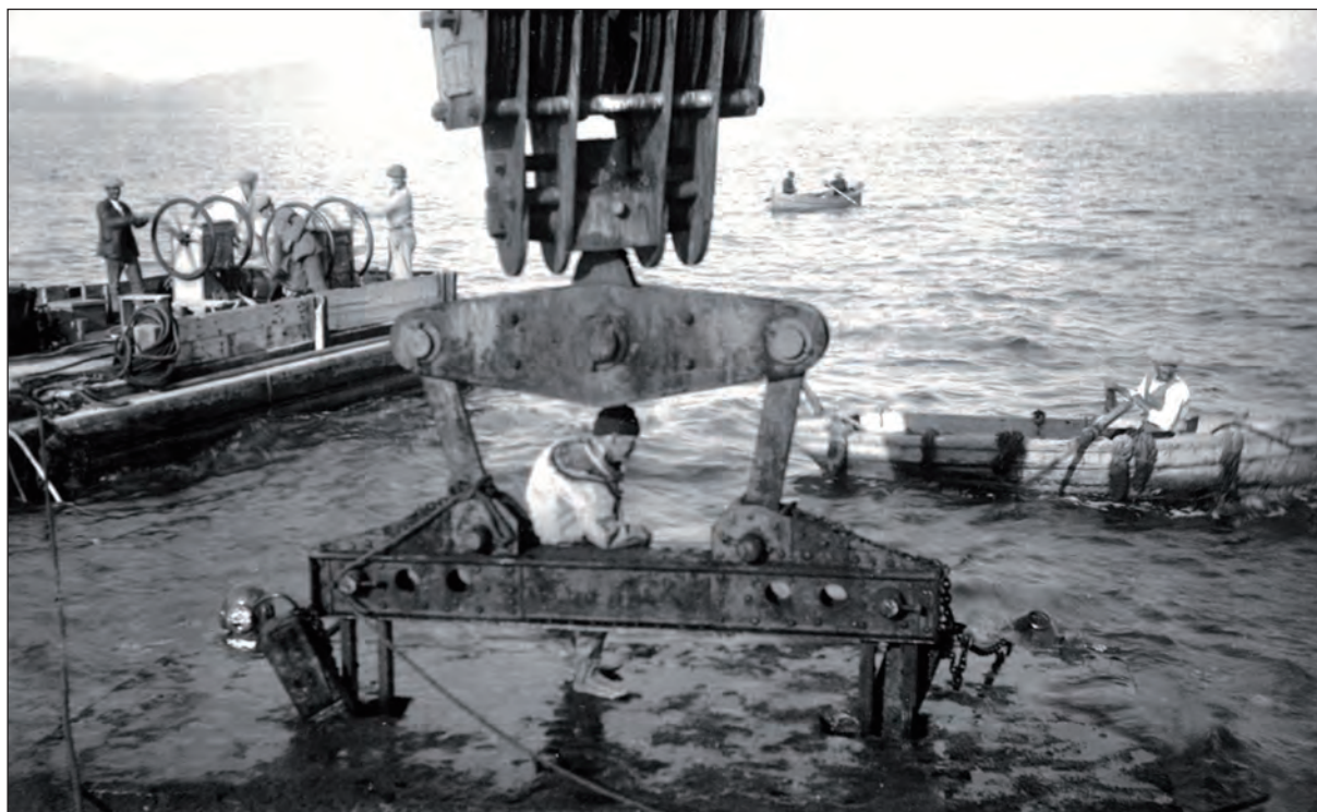
Lámina 14. Las tenazas del "Titán" colocando un bloque con la ayuda de un buzo. Hacia 1929. (Archivo Fotográfico de la A.P.B.A.)
