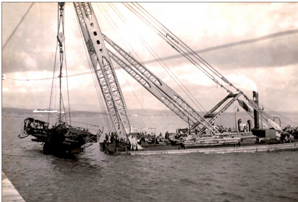
Lámina 15. La grúa flotante "Adelaar" sacando los restos del "Titán" del mar. Diciembre de 1931- enero de 1932. (Archivo Fotográfico de la A.P.B.A.)
