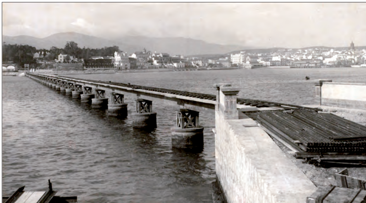
Lámina 8. El puente de la Isla Verde para el tren de obras en construcción. Año 1926 (Archivo Fotográfico de la A.P.B.A.)
