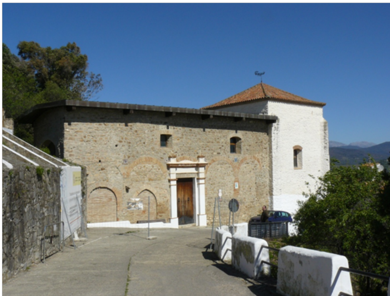
Ilustración nº 2. Estado actual del conjunto. En la fachada lateral se aprecian, de izquierda a derecha: a) Puerta cegada del desaparecido baptisterio. b) Puerta cegada, rematada en arco apuntado y correspondiente a la primitiva portada gótica. c) Puerta que algunos autores tienen por renacentista, hoy desvirtuada al perder el cajeadado. d) Paramento donde se aprecia la disposición arquitectónica interior. e) Cabecera con la capilla mayor.
