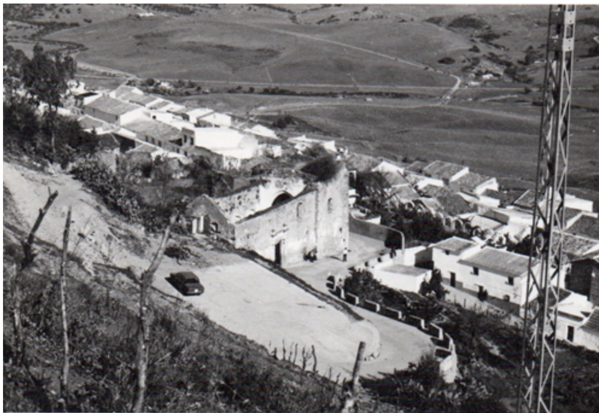
Ilustración nº 1. La iglesia de N. S. de La Misericordia y su entorno antes de la restauración. Fotografía de los años ochenta del S. XX, tomada desde el antiguo recinto medieval, hoy llamado El Castillo. Puede apreciarse la fuerte inclinación de la ladera donde se edificó el templo.
