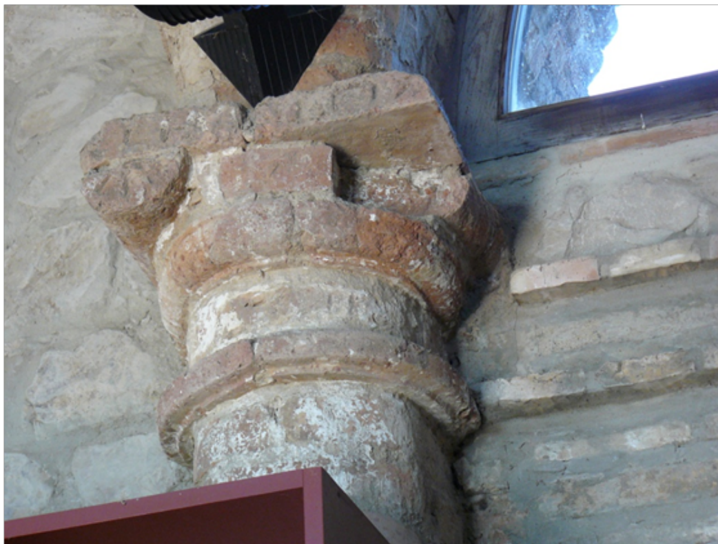
Ilustración nº 6. Este capitel, al haber perdido la parte baja de una de sus volutas jónicas, permite perfectamente apreciar su construcción totalmente funcional en base a un conjunto de pequeñas piezas de barro cocido.
