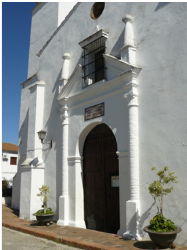
Ilustración nº 7. Portada de la iglesia del antiguo Convento de Santa Ana o de la Victoria, resuelta en ladrillo con técnica constructiva y diseño de elementos idénticos a los utilizados de la Iglesia de la Misericordia.
