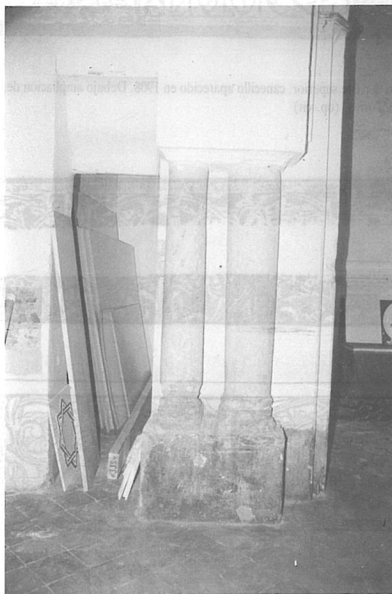
Columnas reaprovechadas en el arco de la Capilla Mayor.
