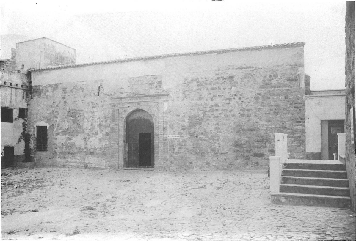
Fachada exterior de la Nave del Evangelio.
