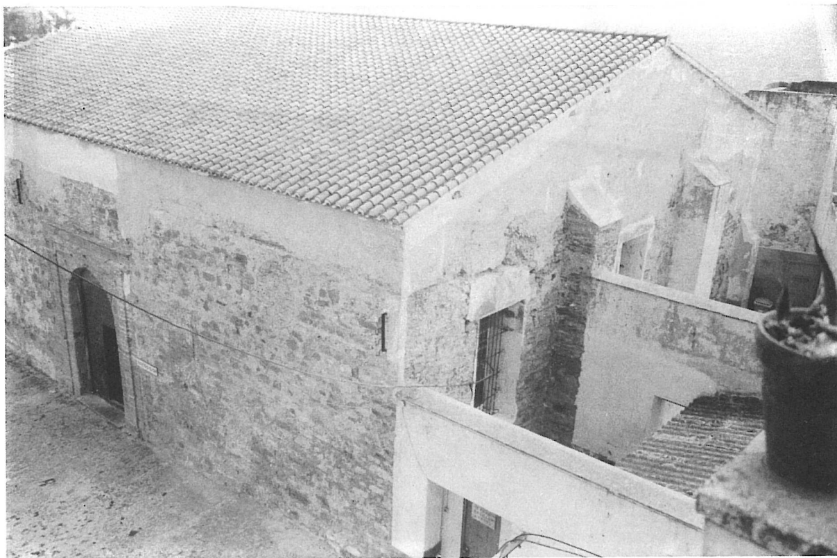
Vista general desde el Castillo. Pueden apreciarse los contrafuertes en la fachada de los pies.
