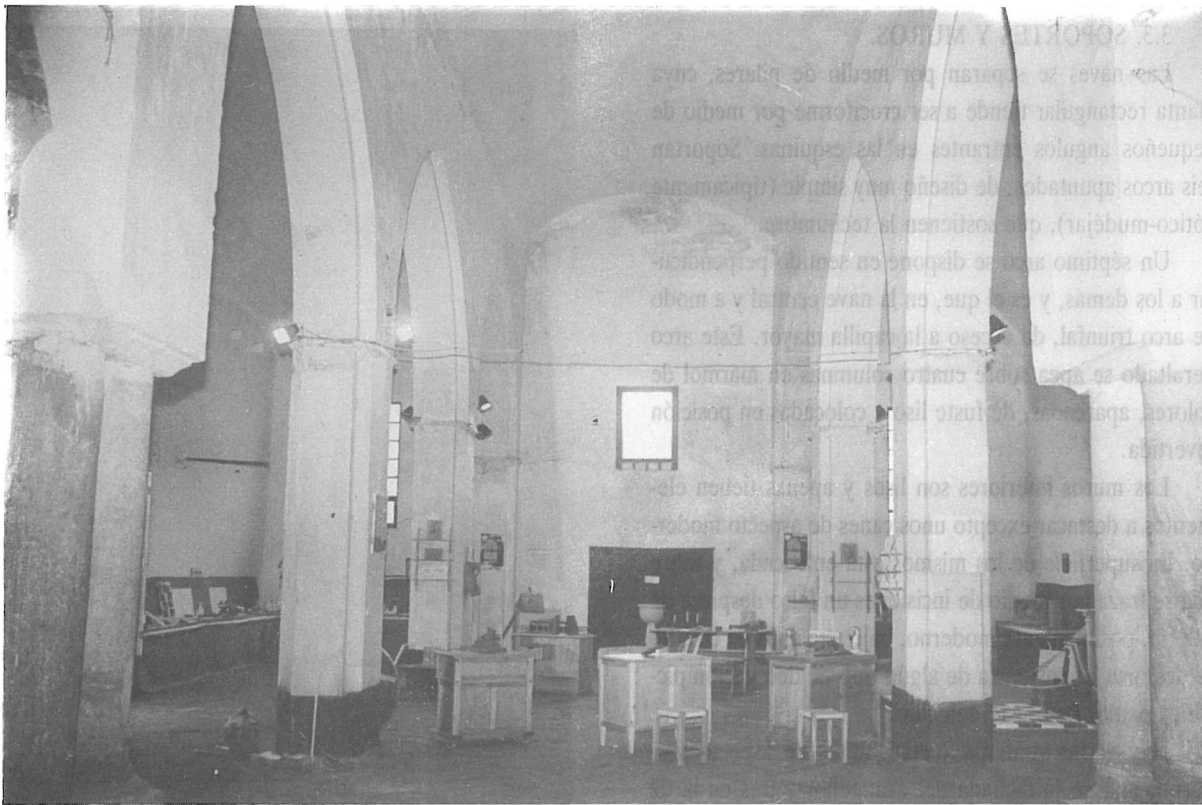
Vista general desde la Capilla Mayor.
