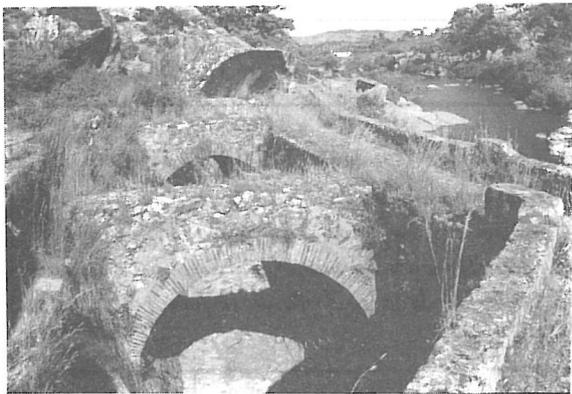
Una vista del estado actual del canal del río Hozgarganta, que alimentaba de agua a la fábrica. Se pueden observar los contrafuertes para contrarrestar el empuje del terreno, cuyo movimiento originó numerosos problemas en las presas y en el canal.
