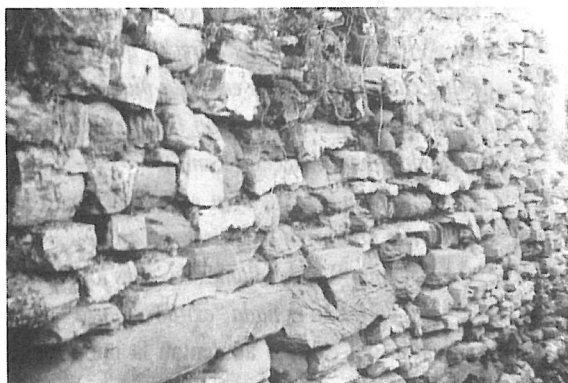
Mampuesto de la muralla del primer sector. Huerto de las Tatas.
