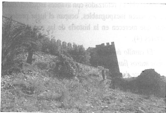
Muro principal y barbacana (Fortaleza de Castellar de la Frontera).
