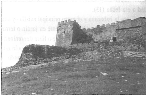
Barbacana suroeste y torre de flanqueo.
