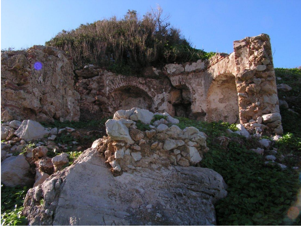
Torre de la playa, junto a la desembocadura de uno de los arroyos en Beliunes
