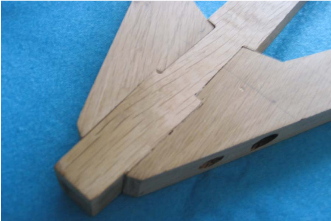
Figura 10.- Unión en forma de rayo de Júpiter.
