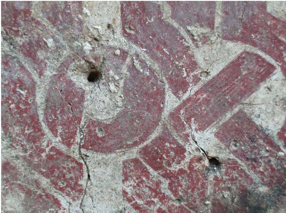
Lámina 7.- Detalle del agujero en la pared para que agarre la nueva capa de cal.
