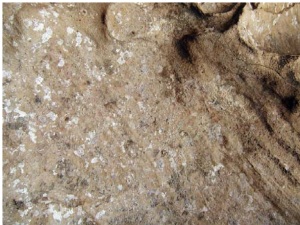
Algunas figuras se encuentran afectadas por líquenes
