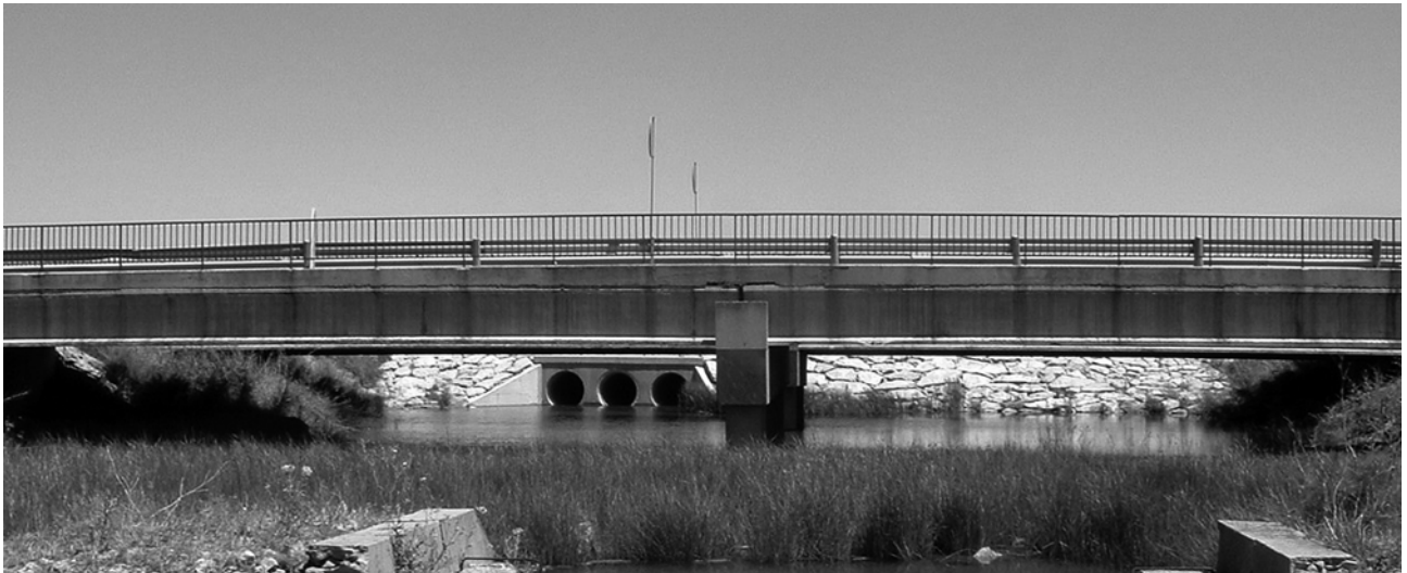
Fotografía 1.- Esta imagen es un ejemplo de la incorrecta planificación existente en el proceso urbanizador de las vegas del río Palmones (ver el subapartado 2.h)
