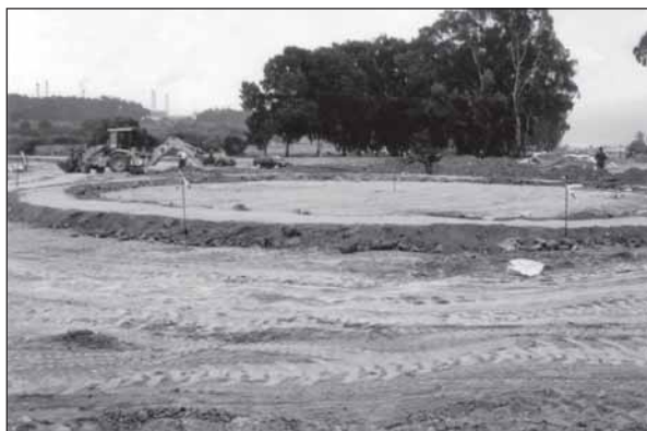
Figura 3. Construcción de una rotonda en el P.K.0+600.
