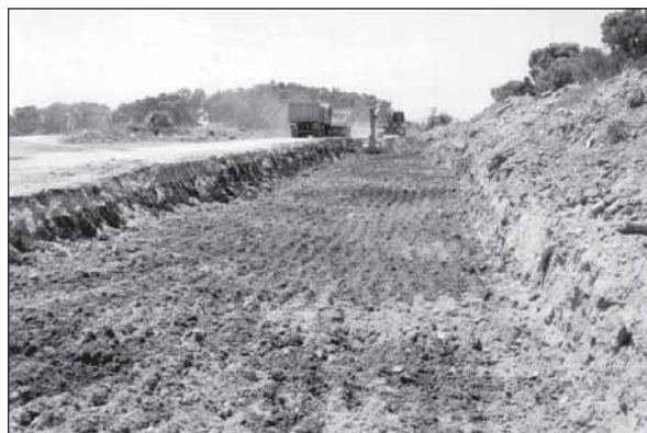
Figura 2. Desmote del terreno del P.K.0+340 al P.K.0+600.
