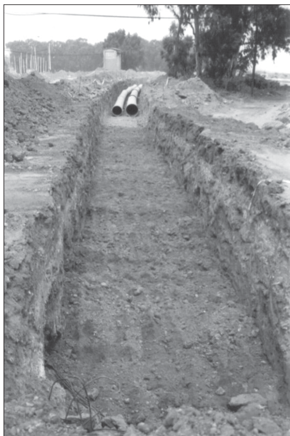
Figura 4. Instalación de tuberías de impulsión y descarga.
