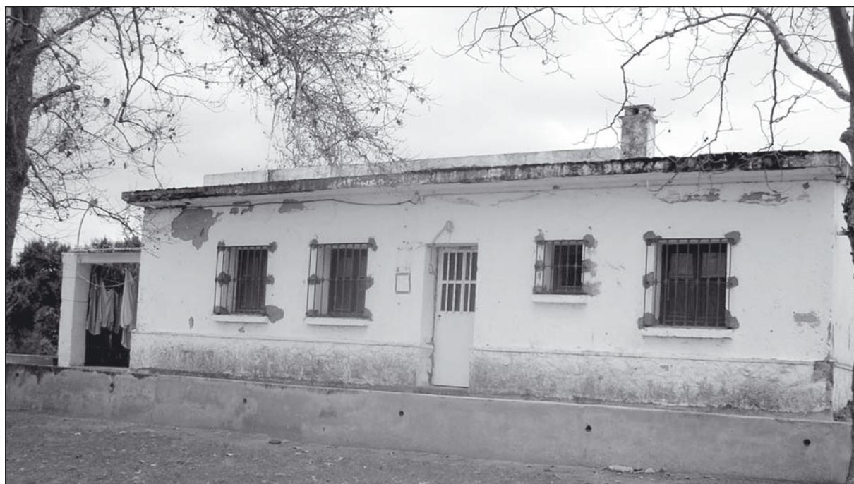
Figura 2. Fachada de una antigua escuela.
