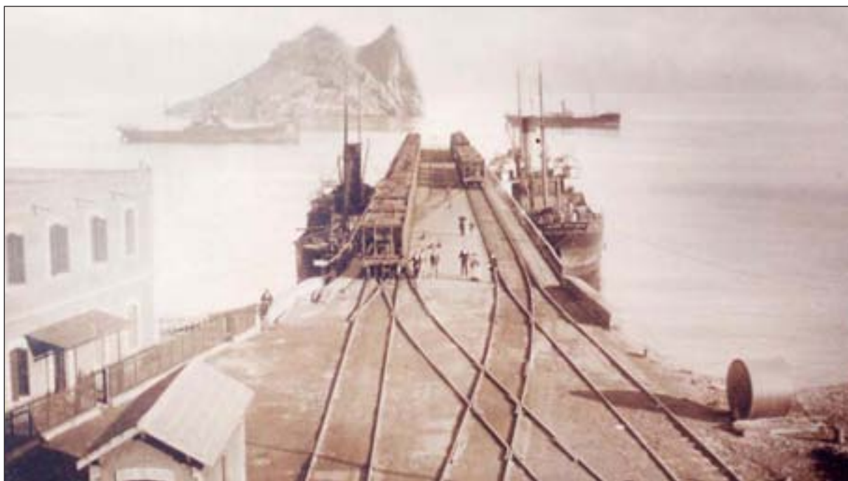
Figura 3. Fotografía antigua del descargadero de mineral de la bahía del Hornillo en Murcia.
