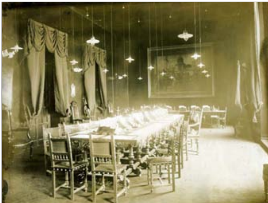
Figura 8. Ayuntamiento de Algeciras.
