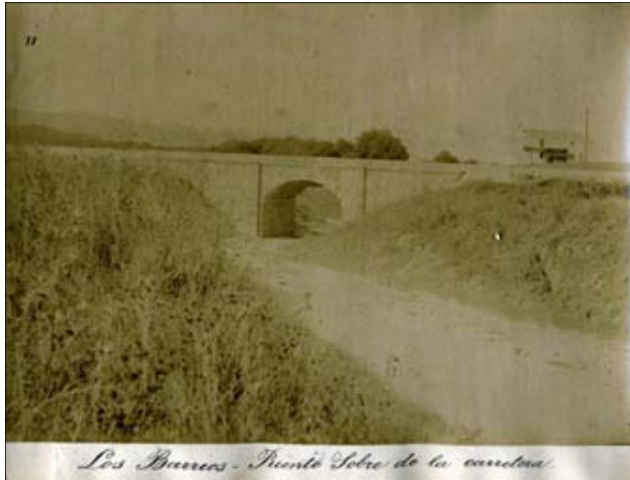
Figura 1. Los Barrios. Puente sobre de (sic) la carretera.
