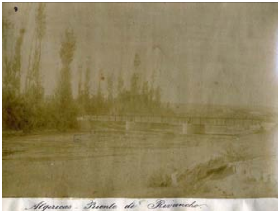
Figura 2. Algeciras. Puente de Rivancho.
