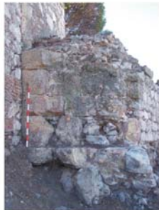
Fig. 3. Jamba Este de la Puerta de Granada.
