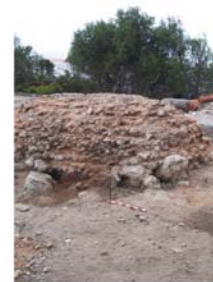
Fig. 5. Base de la Torre de flanco W.
